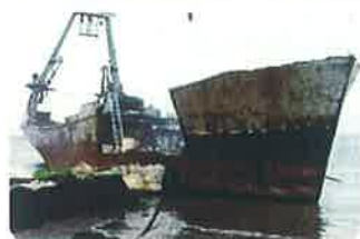
利尻島沖で座礁した船の解体風景
